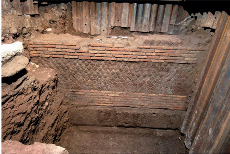
VIA SORA, SAGGIO B1 – MURO IN OPERA QUADRATA CON SOVRAPPOSIZIONE IN OPERA MISTA (US 188):
